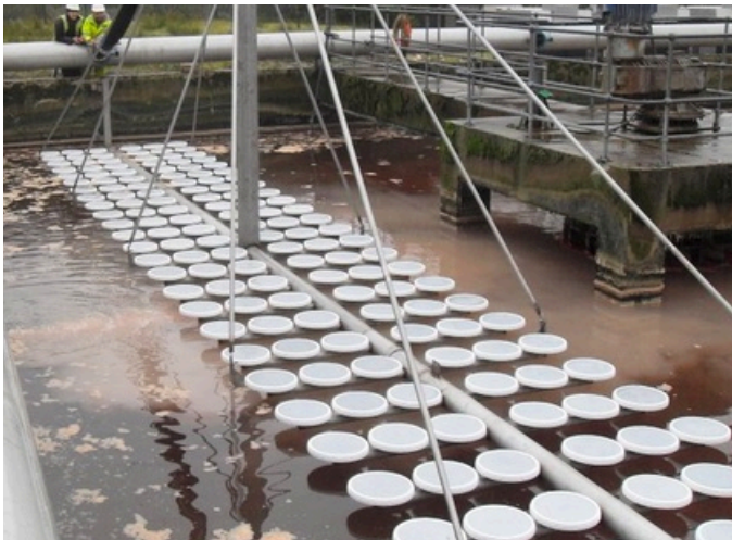
Sistemas izables con grúa con difusores de disco (a la izquierda) y tubulares (a la derecha)
